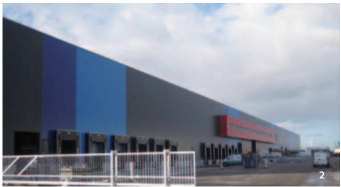
* 1/2. 新建成的 Moerdijk 物流集散中心 3. 仓储
